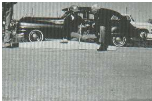
Ilustración 28: Depresión de Severidad baja
