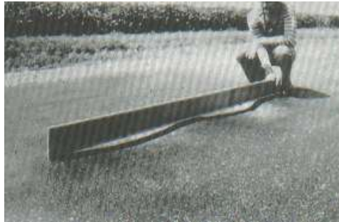
Ilustración 27: Corrugación de severidad alta
