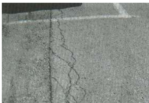
Ilustración 32: Grieta de borde de severidad media
