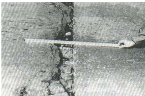
Ilustración 108: Descascaramiento de alta severidad
