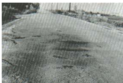
Ilustración 55: Desplazamiento de Severidad alta
