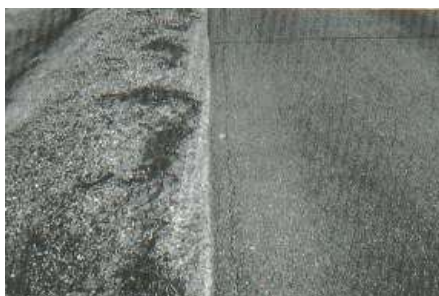
Ilustración 32: Grieta de borde de severidad media
