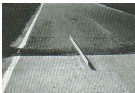
Ilustración 55: Desplazamiento de Severidad alta
