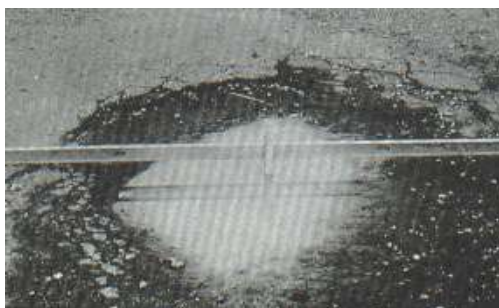
Ilustración 49: Huecos de severidad alta
