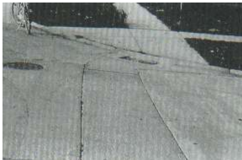
Ilustración 87: Parche grande y acometidas de servicios públicos de baja severidad
