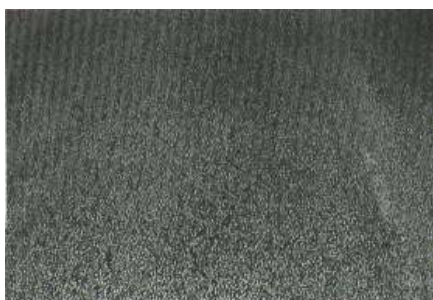
Ilustración 13: Piel de cocodrilo Nivel Bajo
