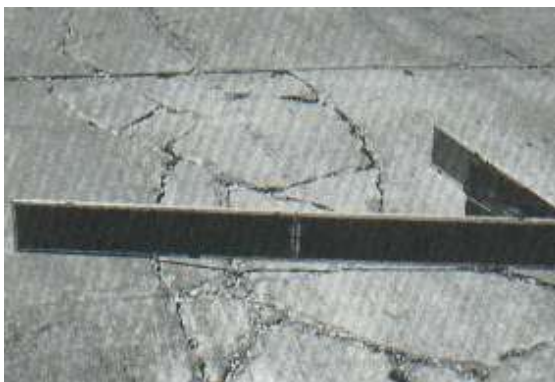
Ilustración 98: Punzonamiento de alta severidad
