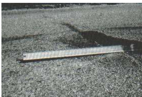
Ilustración 22: Abultamientos y hundimientos de severidad baja
