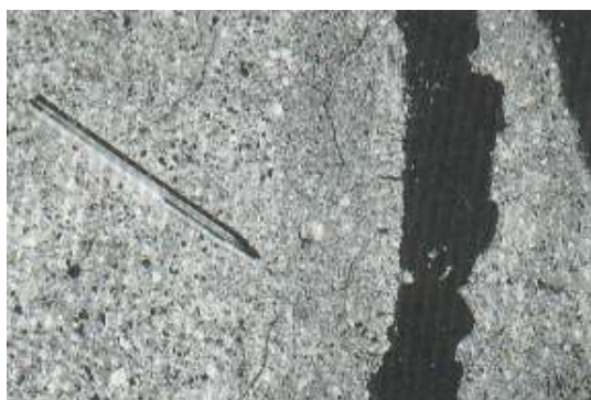
Ilustración 73: Grietas de durabilidad “D” de media severidad
