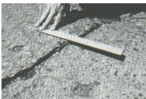
Ilustración 76: Escala de media severidad
