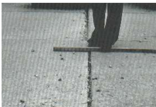
Ilustración 75: Escala de baja severidad
