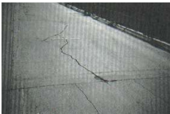
Ilustración 70: Losa dividida de severidad media
