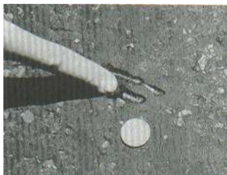
Ilustración 17: Exudación Nivel Medio
