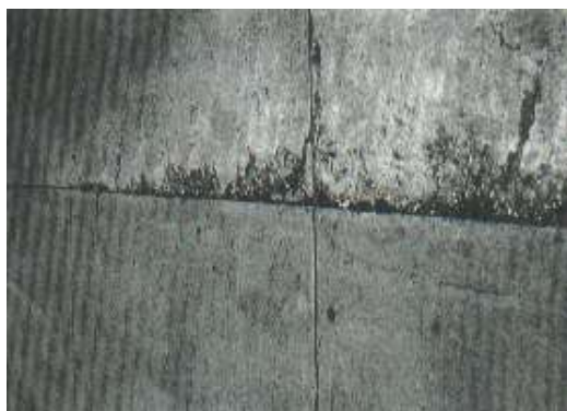
Ilustración 108: Descascaramiento de alta severidad
