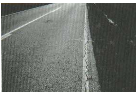
Ilustración 14: Piel de cocodrilo Nivel Medio
