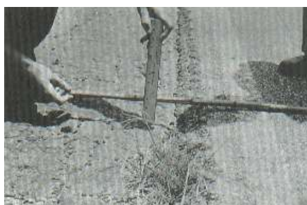
Ilustración 38: Desnivel Carril/Berma de Severidad media
