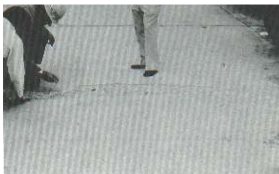
Ilustración 73: Grietas de durabilidad “D” de media severidad
