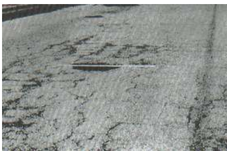
Ilustración 49: Huecos de severidad alta
