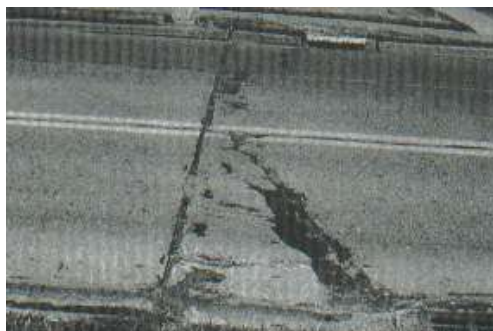
Ilustración 98: Punzonamiento de alta severidad
