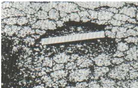
Ilustración 48: Huecos de Severidad media
