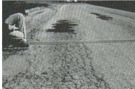
Ilustración 15: Piel de cocodrilo Nivel Alto
