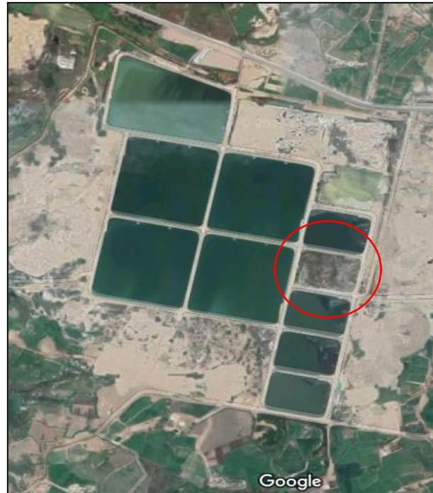
Figura 30 Laguna de lodos donde están almacenado los lodos actualmente para su total deshidratación.
