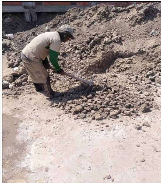
Figura 38 Molienda de suelo arcilloso manualmente
