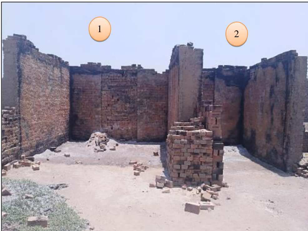
Figura 82 Horno artesanal de la ladrillera seleccionada
