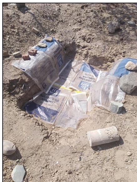
Figura 33 Acondicionamiento de Lodos para su deshidratación
