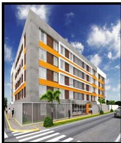
Figura 1. Vista esquina del BLOCK A del Edificio Multifamiliar Paseo Pacasmayo
