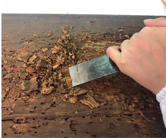
**Figura 43.** Remoção da madeira afetada com o auxílio de um formão.
