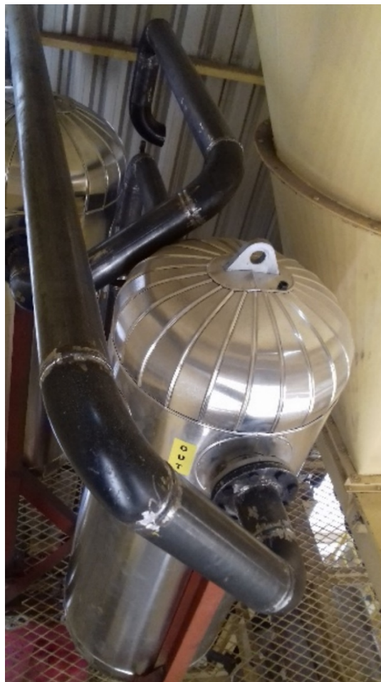
Fig.15 Separador de gotas y micelas de vapor (Frango Rico – Brasil)
