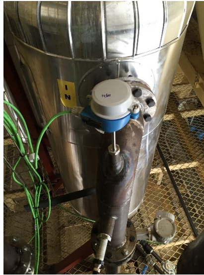
Fig.16 Transductor de presión a la entrada del separador (Endress&Hausser-Frango Rico- Brasil)
