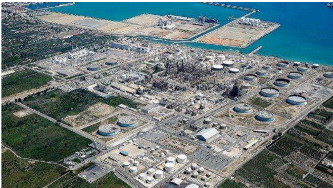
Ilustración 3: Vista aérea de las instalaciones de la refinería
