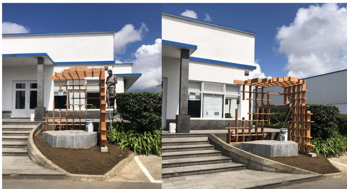
**Figura 114** - Registo fotográfico da aplicação da estrutura de madeira no local de implementação. Fonte: Paula Sousa.
