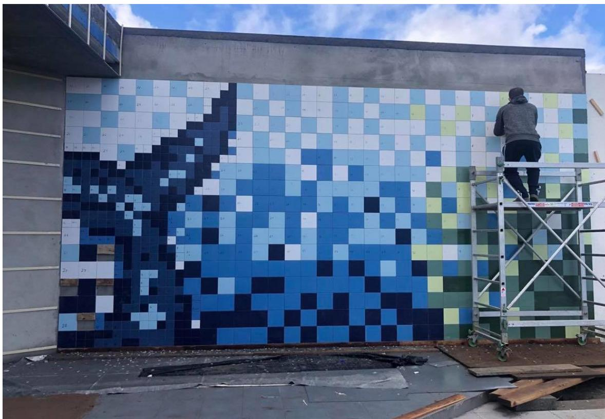
**Figura 136** - Montagem do painel cerâmico na parede. Fonte: Paula Sousa.
