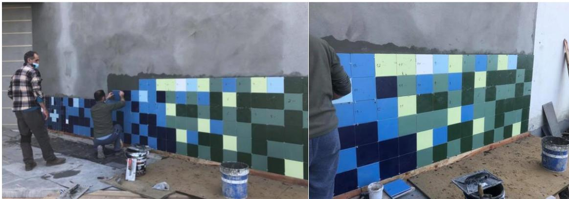
**Figura 135** - Montagem do painel cerâmico na parede. Fonte: Paula Sousa.
