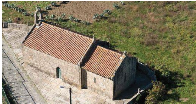
Figura 15 - Entorno Capela Nossa Senhora da Piedade
