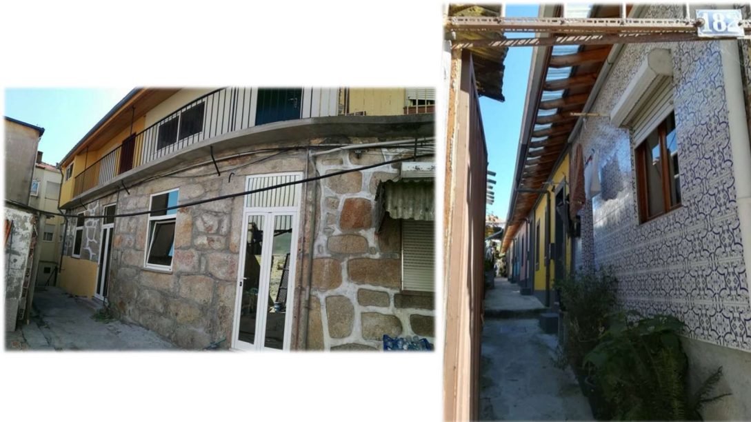
Figura 13 - Casa pertencente à "ilha" nº 116 em obras e casas modificadas da "ilha" nº 182
