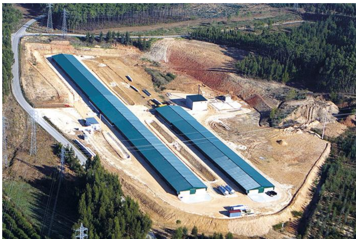
Figura 3.1 – Exploração Avícola em construção
