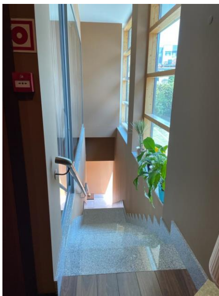
Figura 18 Escadas de acesso ao exterior do edifício localizadas após a área de recepção do Spa.
