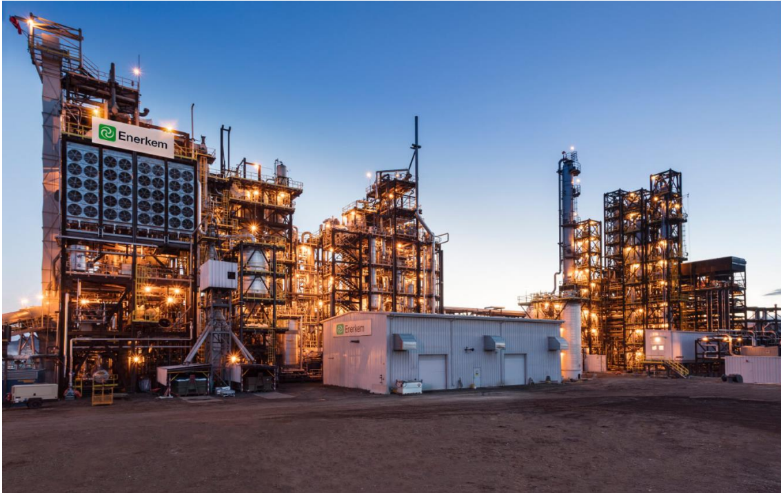
Figura 17: Enerkem Alberta Biofuels LP Canada, biorrefinaria de Bioetanol de 2ª Geração, Edmonton, Canadá ( Enerkem Alberta Biofuels, 2021 ).
