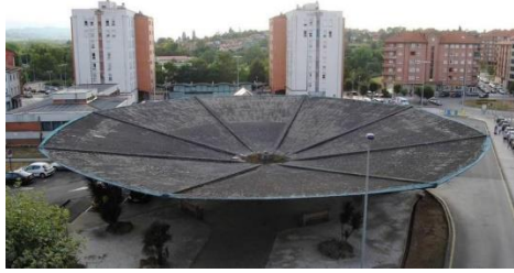
Imagem 36 - Guarda-chuva invertido de Sánchez del Río, estrutura em betão, em Oviedo: Praça do Guarda-Chuva, 1931. Imagem retirada a 16.07.2021 do site: https://estaticos-cdn.prensaiberica.es/clip/3685f19f-8b5e-412d-adfb-b1feafd169af_16-9-aspect-ratio_default_0.jpg
