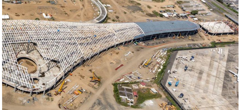
Imagem 64 - Momento da construção do edifício. Imagem retirada a 27 de outubro de 2021 do site fosterandpartners.com, Structural Engineering, p. 77.
