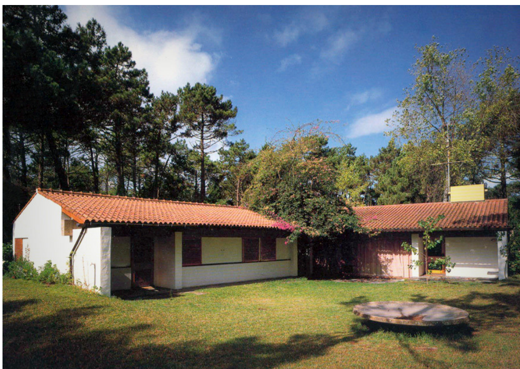
Fig. 3 - Pátio principal da Casa de Ofir juntamente com a parte privada e social da Habitação.
