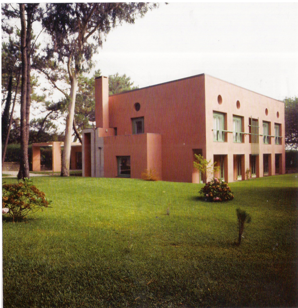
Fig. 17 - Vista do exterior da casa.
