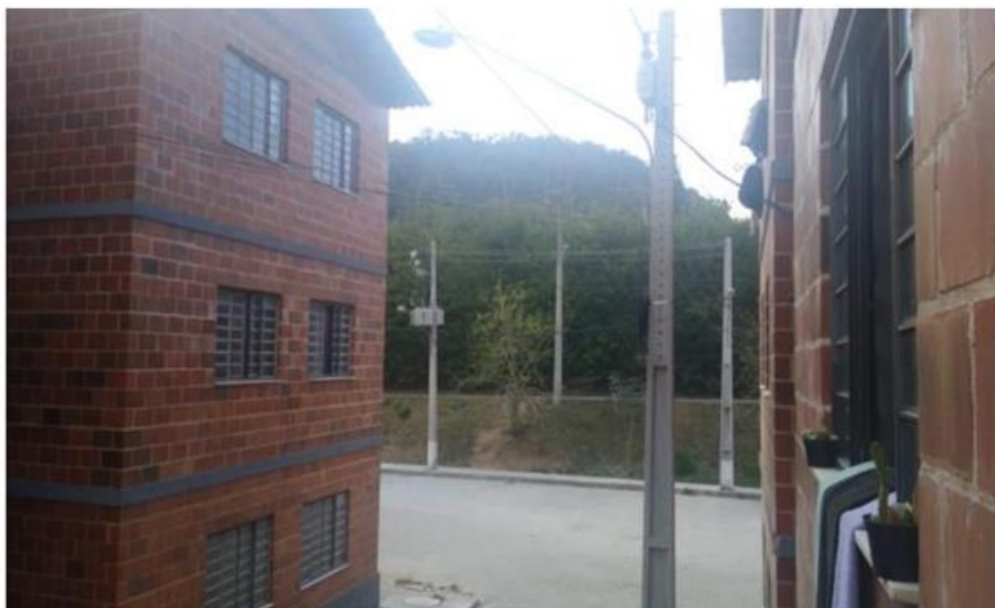
Figura 60 – Ocupação do conjunto habitacional sem finalização da obra.
