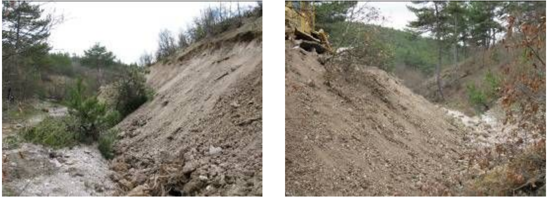
Şekil 6: Kazı materyalinin dere tabanına akması
