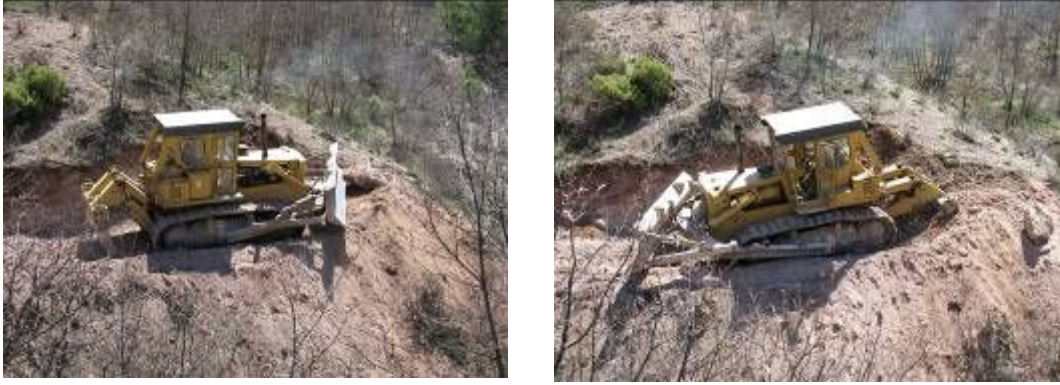
Şekil 3: Kayalık alanlarda riperin kullanılması
