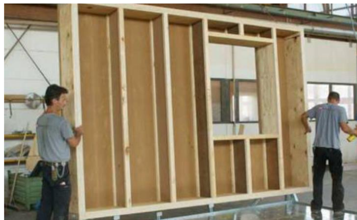
Figura 54: Prefabrico de paneles en taller
