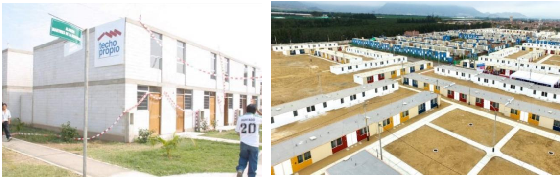
Figura 20, 21: Vivienda social impulsadas por el estado, Techo Propio.
