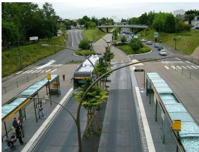
Figura 30. Plataforma central Busway de Nantes.
