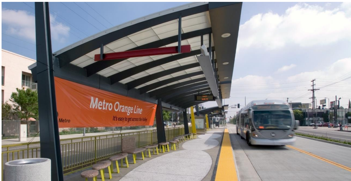
Figura 27. Estació de les parades de bus del Metro Orange Line de Los Angeles.
