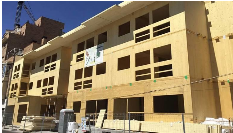
Fig. 38. Proceso constructivo edificio Las Carolinas
