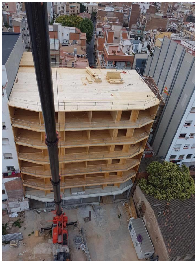
Fig. 31. Proceso constructivo en madera del edificio La Borda
