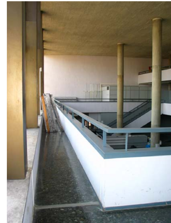
15) PASSARELLA EN FAÇANA A PLANTA PRIMERA
