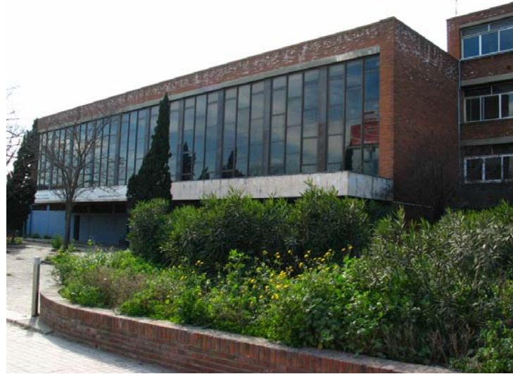
1) FAÇANA D'ENTRADA A L'EDIFICI.
