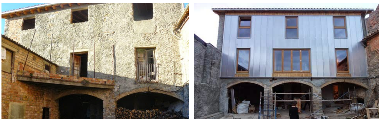
Figura 2-06: Abans i després de la rehabilitació energètica Pessonada, Pobla de Segur. Josep Bunyesc.
