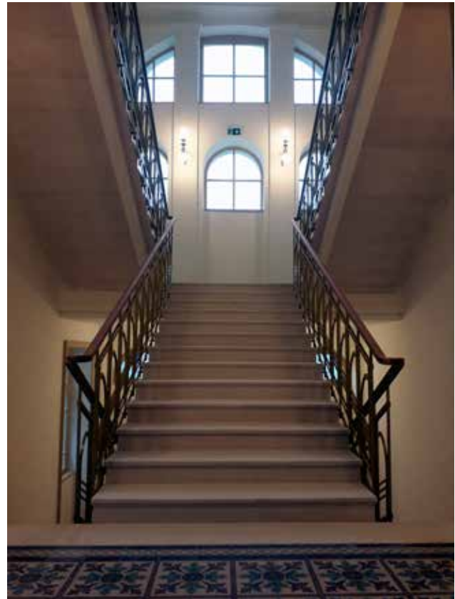
14 Stubište nakon završetka restauratorskih radova; ograda je izrađena kao replika Tončićeve ograde u zgradi Sumpornih toplica (foto: S. Perić, 2020.)
