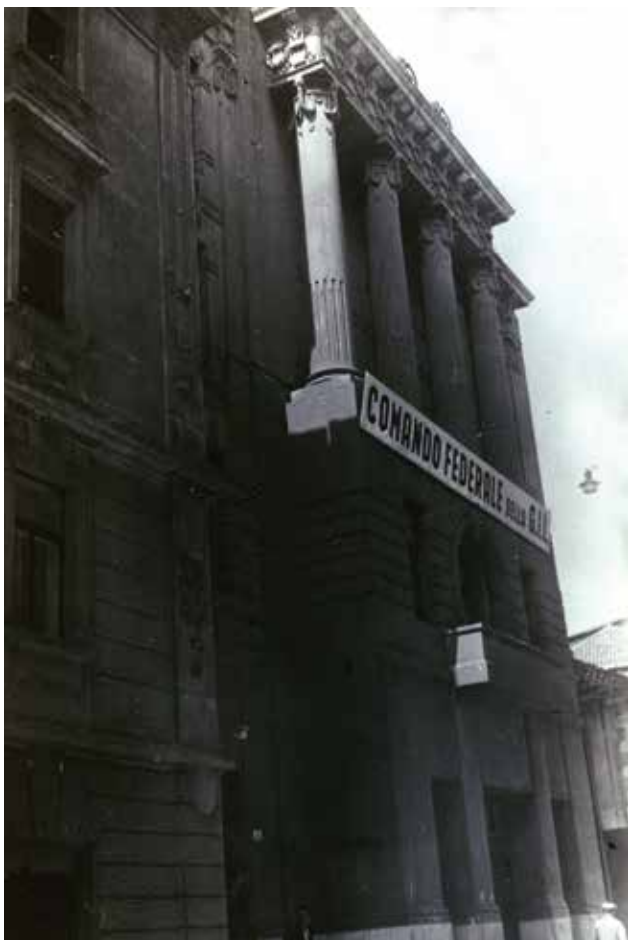
4 Pročelje zgrade, sjedišta talijanske fašističke omladine (Comando federale della GIL), oko 1943. godine (fototeka MGS MREV)
