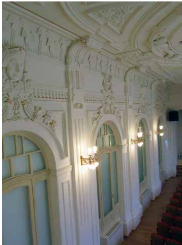
21 Dvorana, pogled na uzdužni zid nakon obnove; u slijepe niše ugrađene su replike izvornih prozora, a zidna rasvjeta izrađena je prema fotografiji interijera iz dvadesetih godina 20. stoljeća (foto: S. Buble, 2020.)
