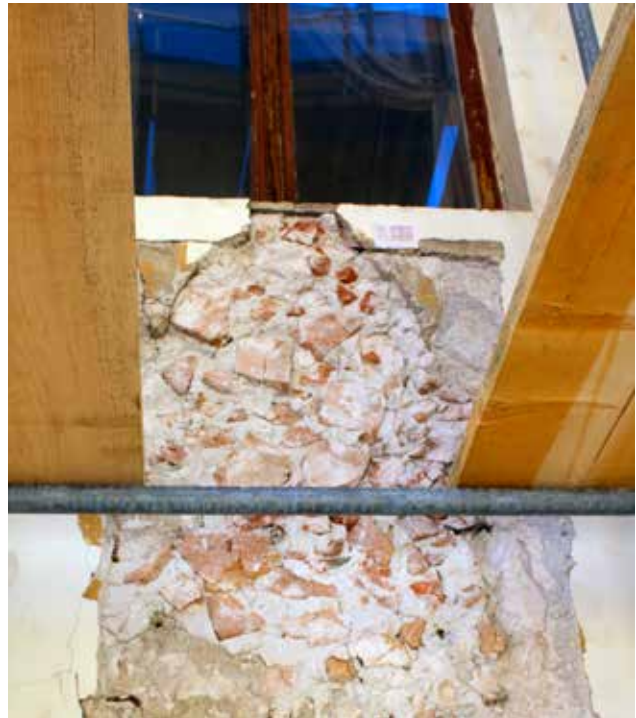
11 Mjesto lijevanog ukrasa na parapetu prozora drugog kata. Ukas je bio podržan željeznim kukama i opšiven grubom žbukom. Nakon skidanja aplikacije šupljina je zapunjena mortom i opekom, a u okolnoj žbuci sačuvane su kuke kojima je bila pričvršćena (foto: Z. Boban, 2017.).
