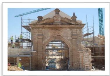
Fig.-2 Puerta del Mar durante su rehabilitación.
