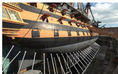
Fig 3. Reconstrucción de dique seco con soportes hidráulicos (Cristina Agudo, 2018).
