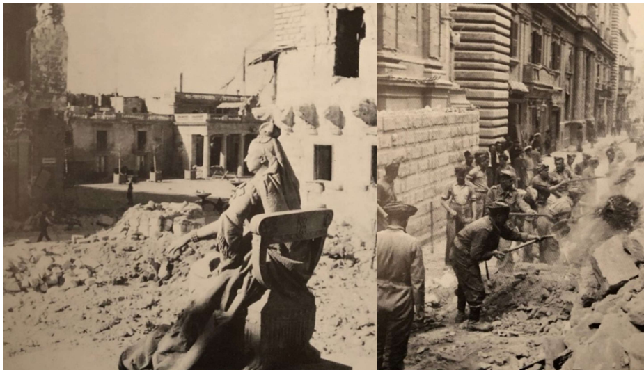
Figura 64. Ruínas na praça Rainha Vitória e limpeza de escombros em La Valetta (Malta).
