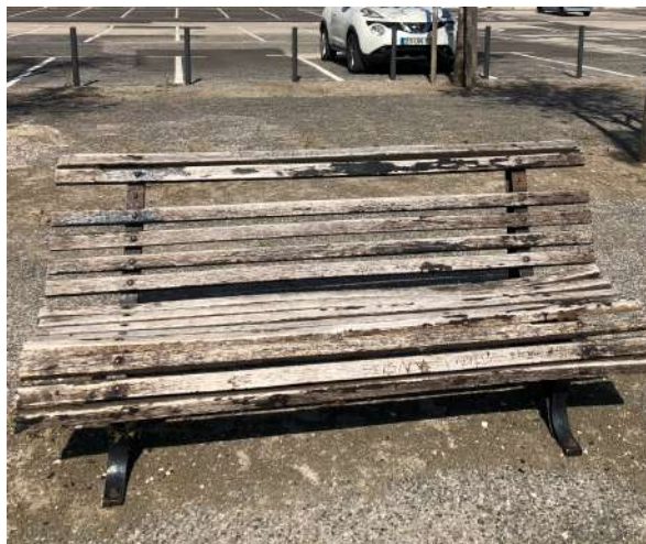
Figura 10: Banco descascado e quebrado Fonte: arquivo pessoal Adriana Sixel
