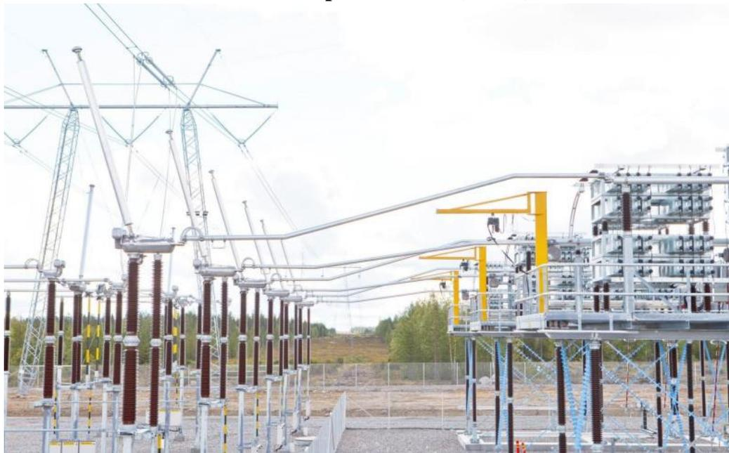
Figura 3. 12 Condensador serie conectado a la línea de transmisión.
