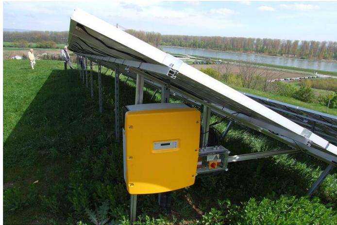
Figura 3. 19 Inversor fotovoltaico.
