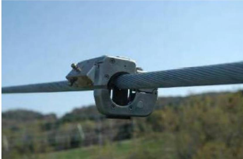
Figura 3. 10 Sensor de corriente de temperatura y corriente de conductor.
