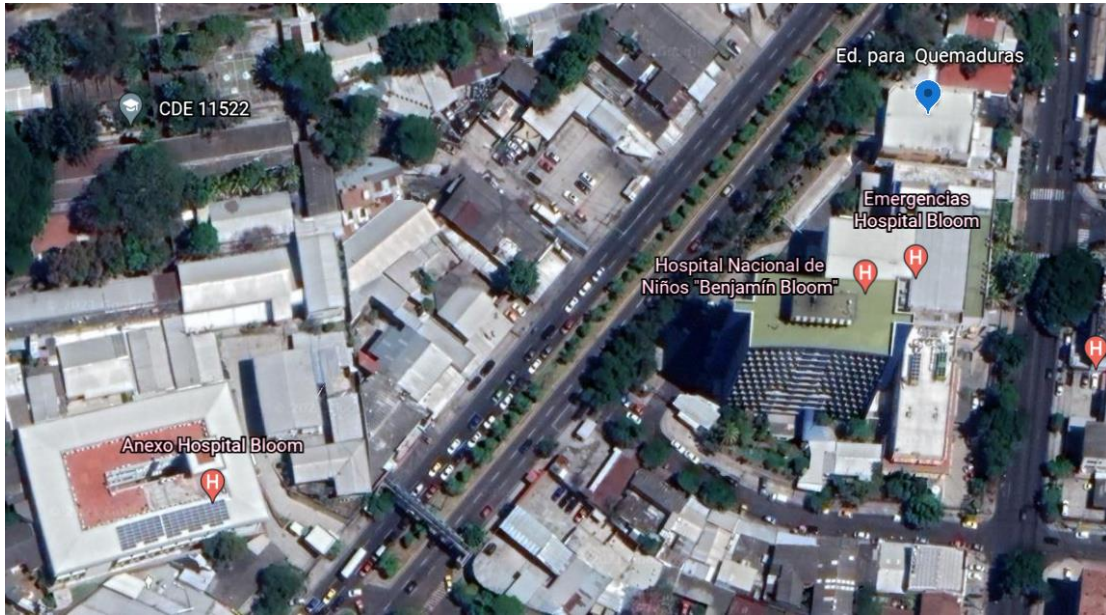
Figura 2 Principales edificios del HNNBB ubicado en Lat.: 13.7138656 y Long.: -89.2039223 (Google Earth).
