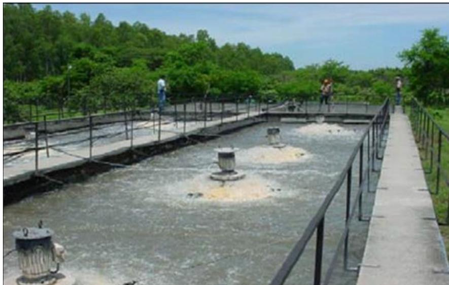
*Figura 2.23 Aireadores superficiales instalados.*
