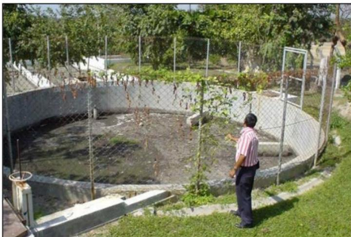
*Figura 2.26. Digestor de lodos en funcionamiento*
