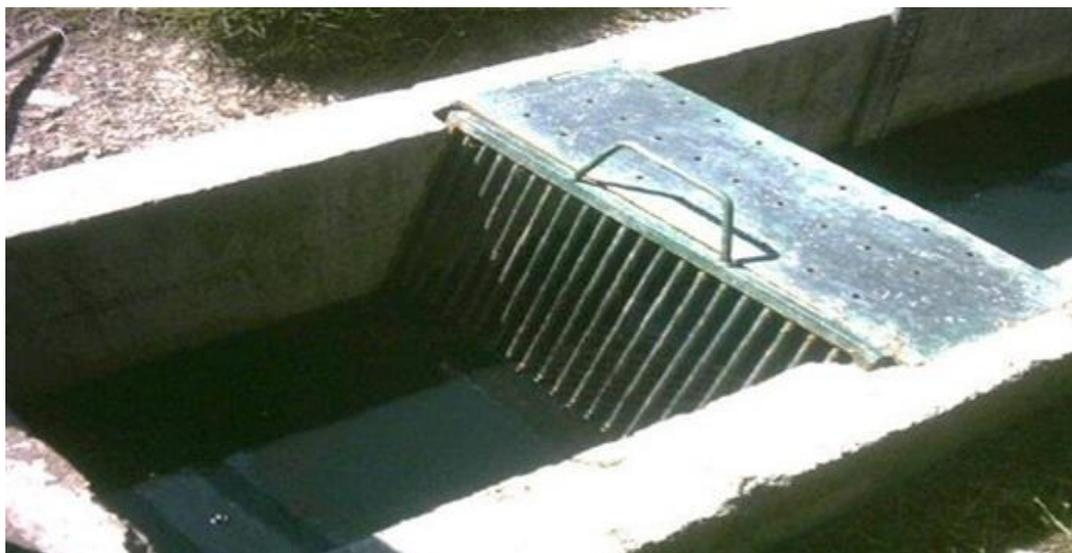
*Figura 2.11. Rejilla media con lámina perforada para escurrimiento del material extraído.*
