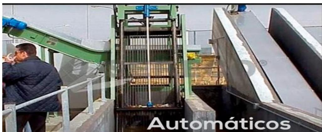
Figura 2.13 Rejillas de limpieza automáticas
