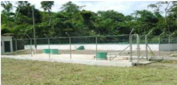
*Figura 2. 4 Figura 2.25. Planta piloto de tratamiento con filtro de medio granular. Fuente: Guía de referencia de Sistema de tratamiento de Aguas Residuales utilizados en Centro América*
