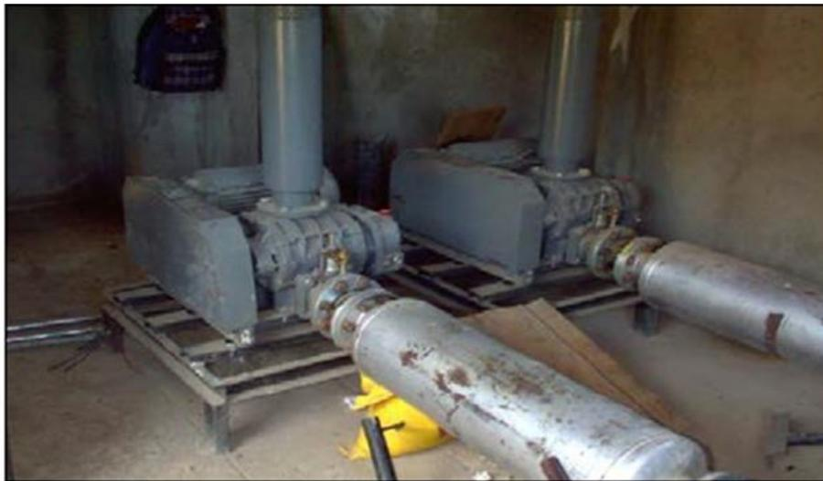
*Figura 2.22. Compresores (blowers) para aireación.*
