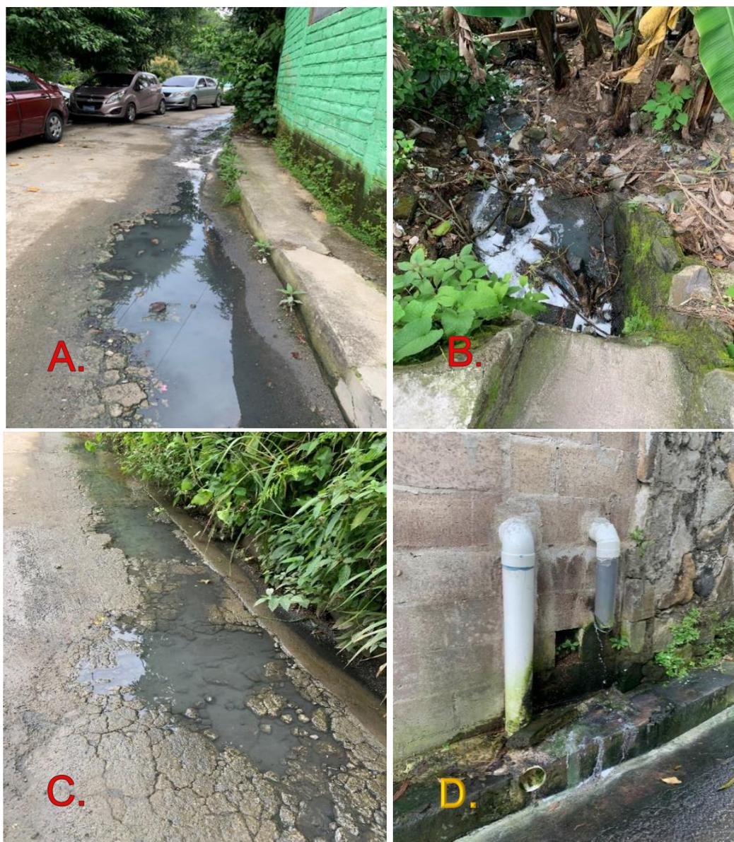
*Figura 3.19 manejo inadecuado de las aguas grises en el casco urbano de San Pedro Perulapán*
