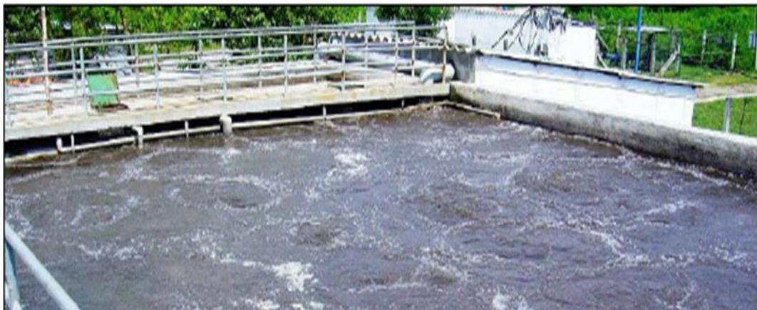
*Figura 2.24. Cubeta de aireación en funcionamiento en una planta de lodos activos.*
