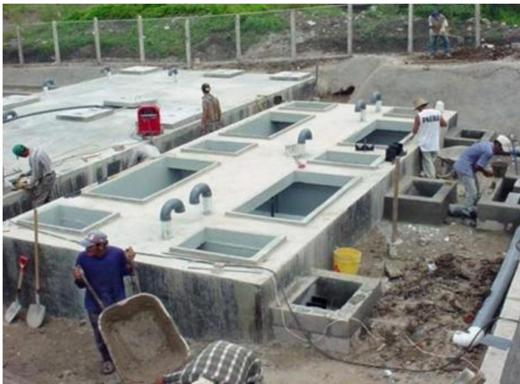
*Figura 2. 3 Construcción de un reactor Anaeróbico de Flujo Ascendente. (RAFA).*
