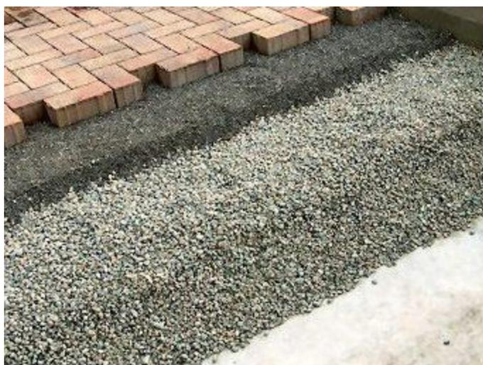
Figura 6. Estructura en campo de un piso permeable.
