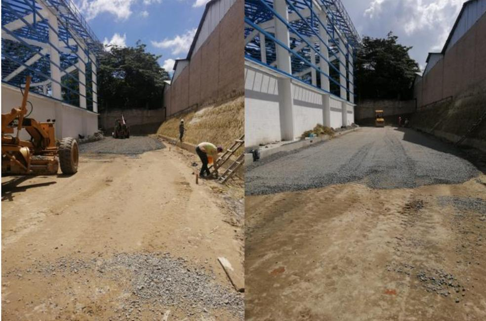
**Figura 31. Conformación de subbase granular.**
