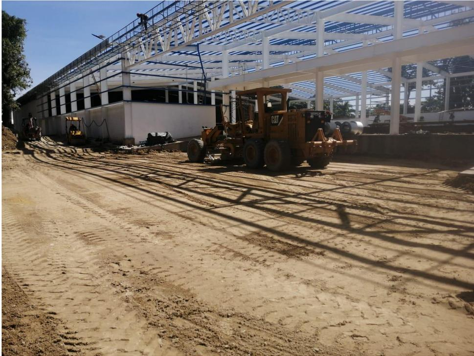
**Figura 27. Proceso de conformación de la subrasante.**
