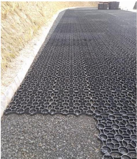
**Figura 2. Sistema de rejillas de plástico en pisos permeables.**
