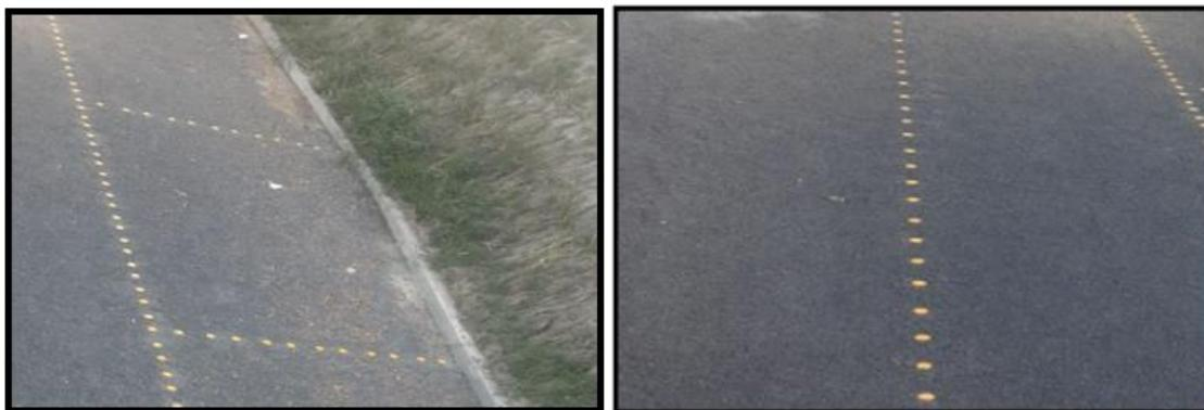
**Figura 13. Superficie de piso con rejillas plásticas y material granular.**
