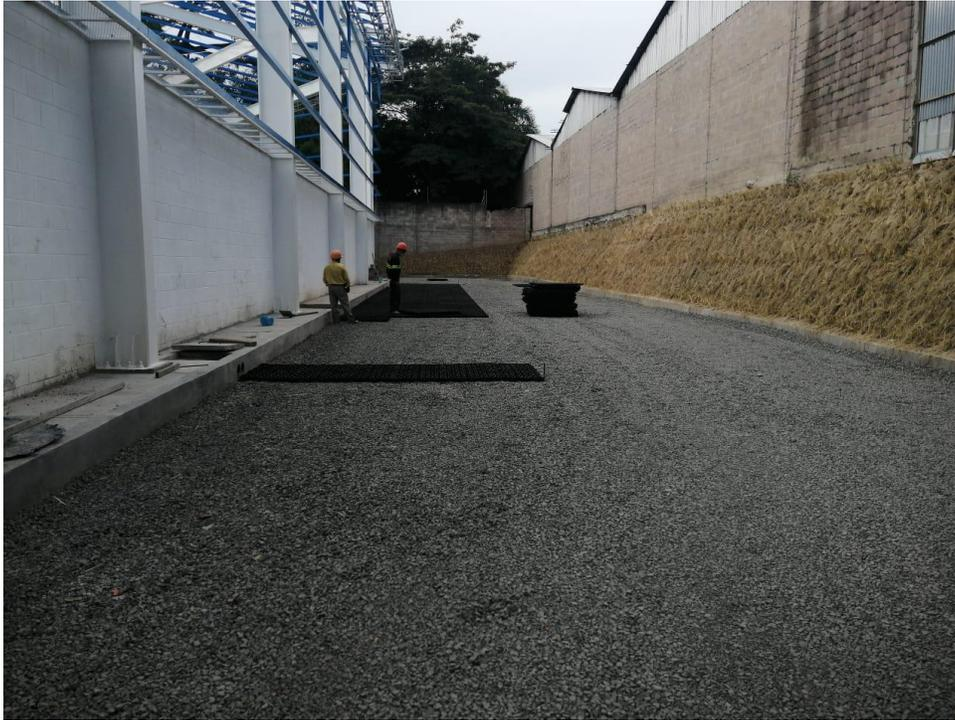
**Figura 33. Colocación de rejillas sobre base granular.**
