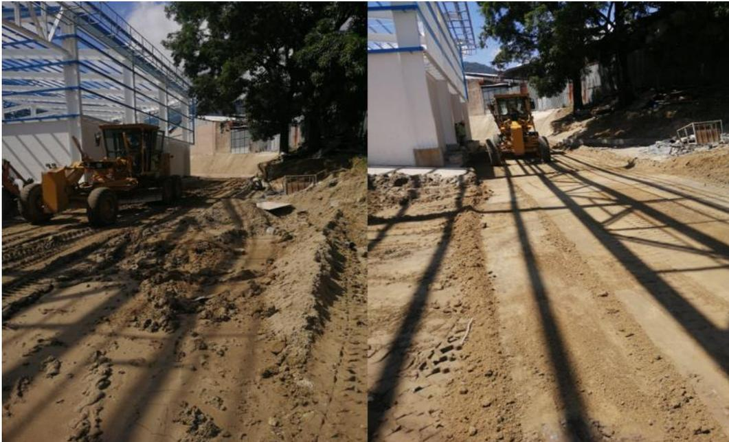
**Figura 28. Proceso de conformación de la subrasante.**
