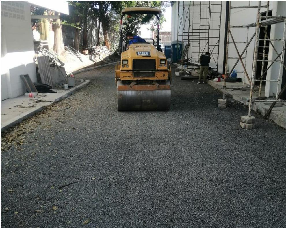
**Figura 32. Compactación de la subbase granular.**
