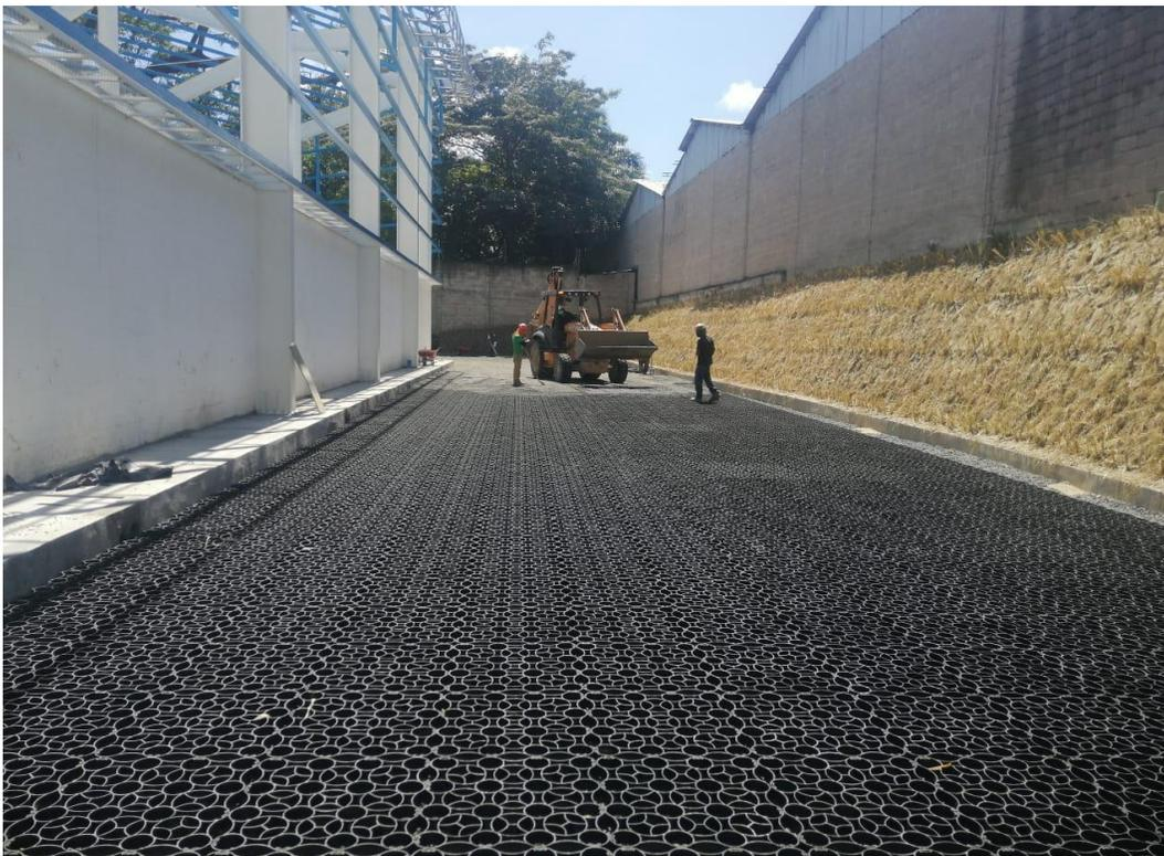
**Figura 38. Sistema de rejillas instaladas, listas para el relleno con material granular.**
