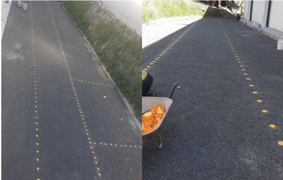
**Figura 39. Sistema de pavimento permeable terminado y demarcación de estacionamientos.**
