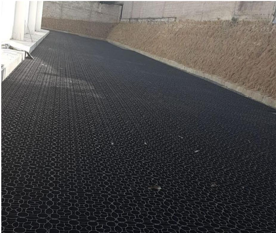
**Figura 37. Sistema de rejillas instaladas, listas para el relleno con material granular.**
