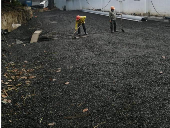
**Figura 42. Conformación de la base después de construir el dren interior.**
