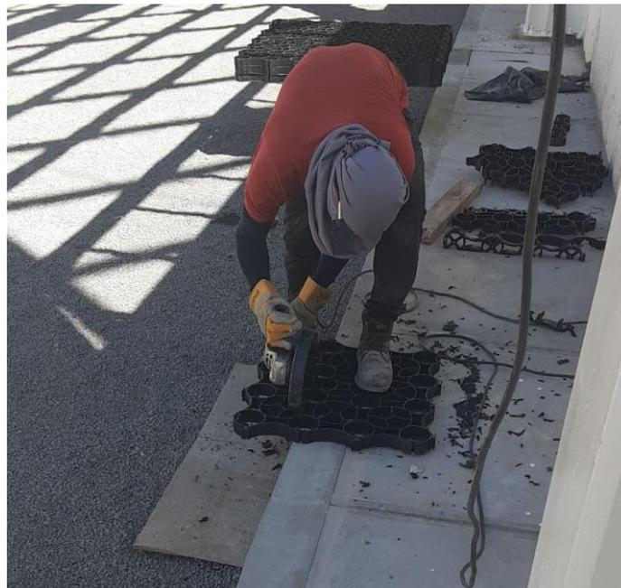
**Figura 35. Corte de rejilla, para ajustarla al área donde se colocará.**
