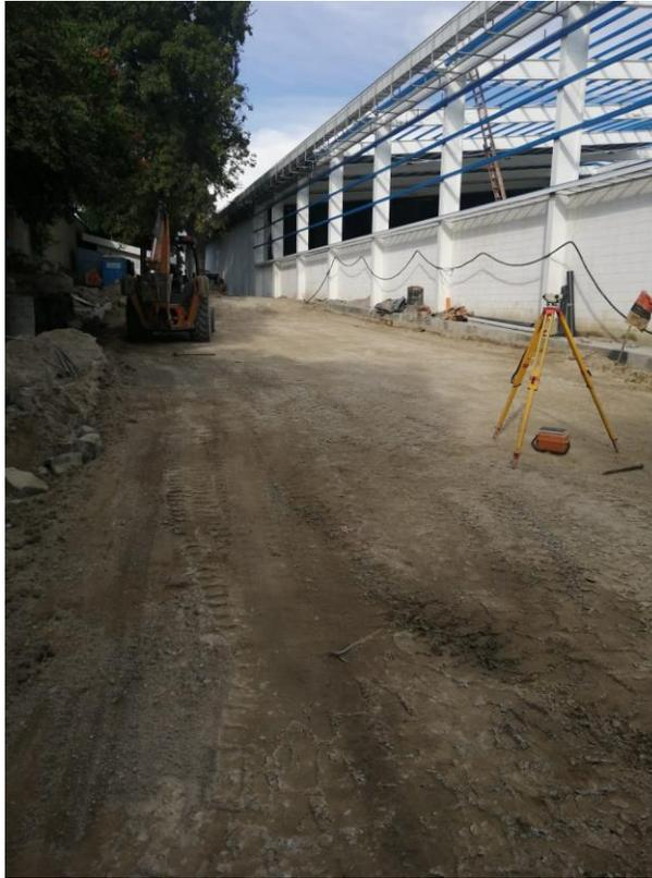
Figura 29. Proceso de conformación de la subrasante.
