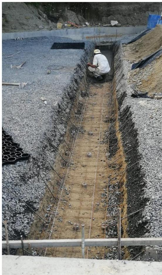
**Figura 41. Construcción de drenaje interno.**
