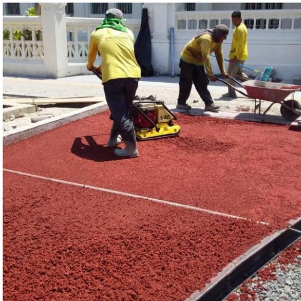
Figura 58. Instalación De Pavimento De Concreto Permeable - (Ex-Casa Presidencial). 10 De junio De 2019.
