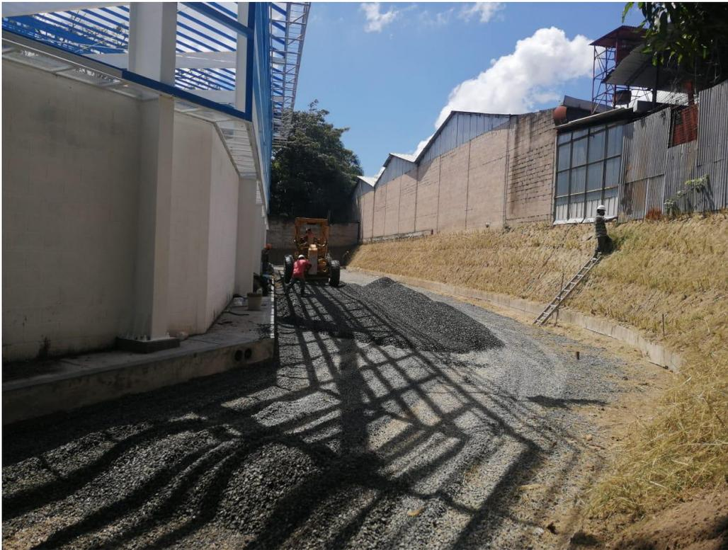
**Figura 30. Proceso de conformación de la subbase.**
