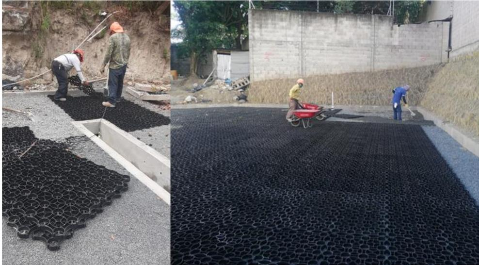
**Figura 34. Colocación de rejillas sobre base granular.**
