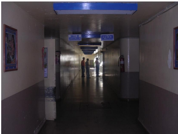
Pasillo principal, entrada al área de hospitalización y sala de operaciones
