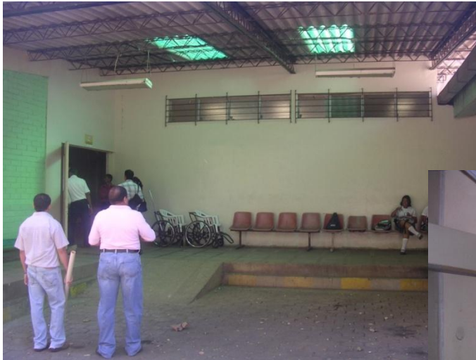
Entrada al área de emergencia
