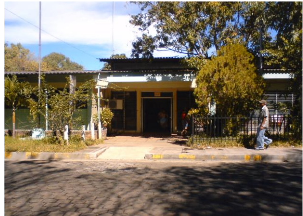
Aquí se observa la entrada del área de consulta externa.
