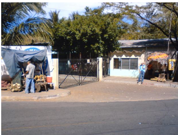
Portón principal para el acceso tanto de vehículos como de peatones.
