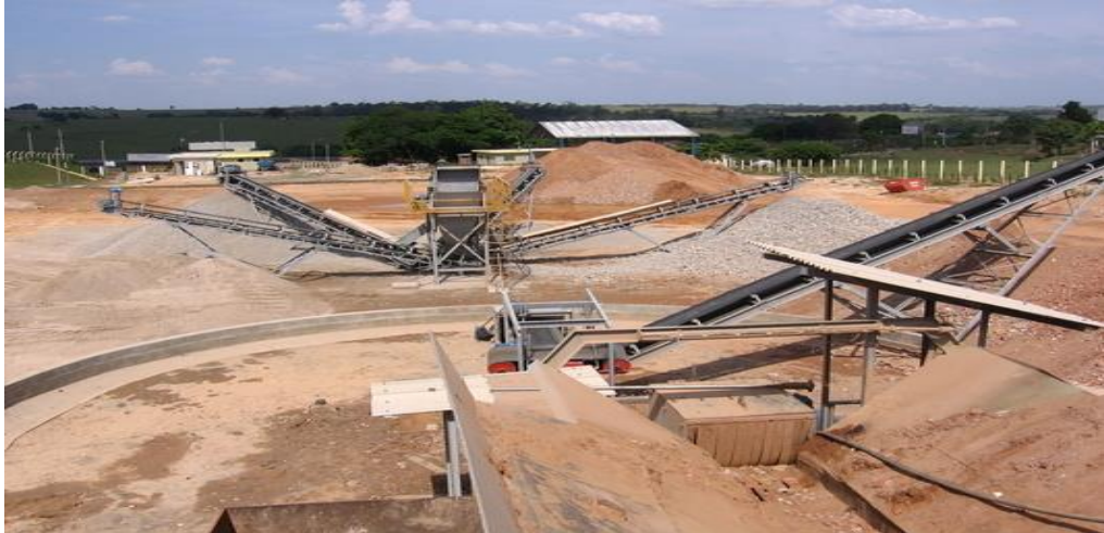
Figura 10. Usina de reciclagem de RCD
