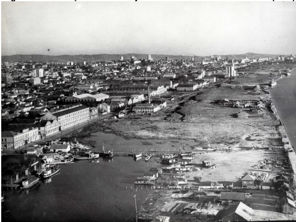
Figura 4 - Construção de aterro adjacente à Rua Voluntários da Pátria (1955)
