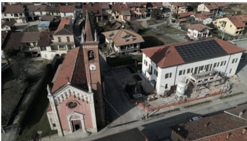
Figg. 5.5 e 5.6 - Impianto fotovoltaico del progetto EnergyCityHall, Comune di Magliano Alpi (CN). Fonte: CER EnergyCityHall, sito ufficiale ©
