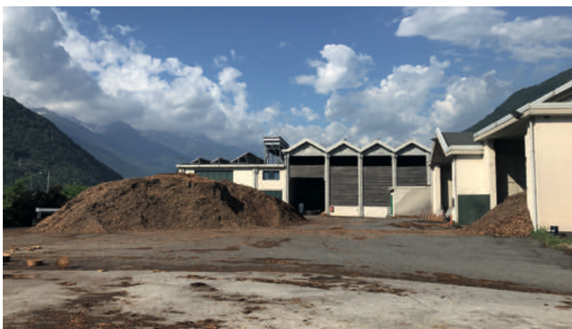
Figg. 5.9 e 5.10 - Impianto di teleriscaldamento a biomassa di TCVVV SpA. Fonte: Luca Tricarico
