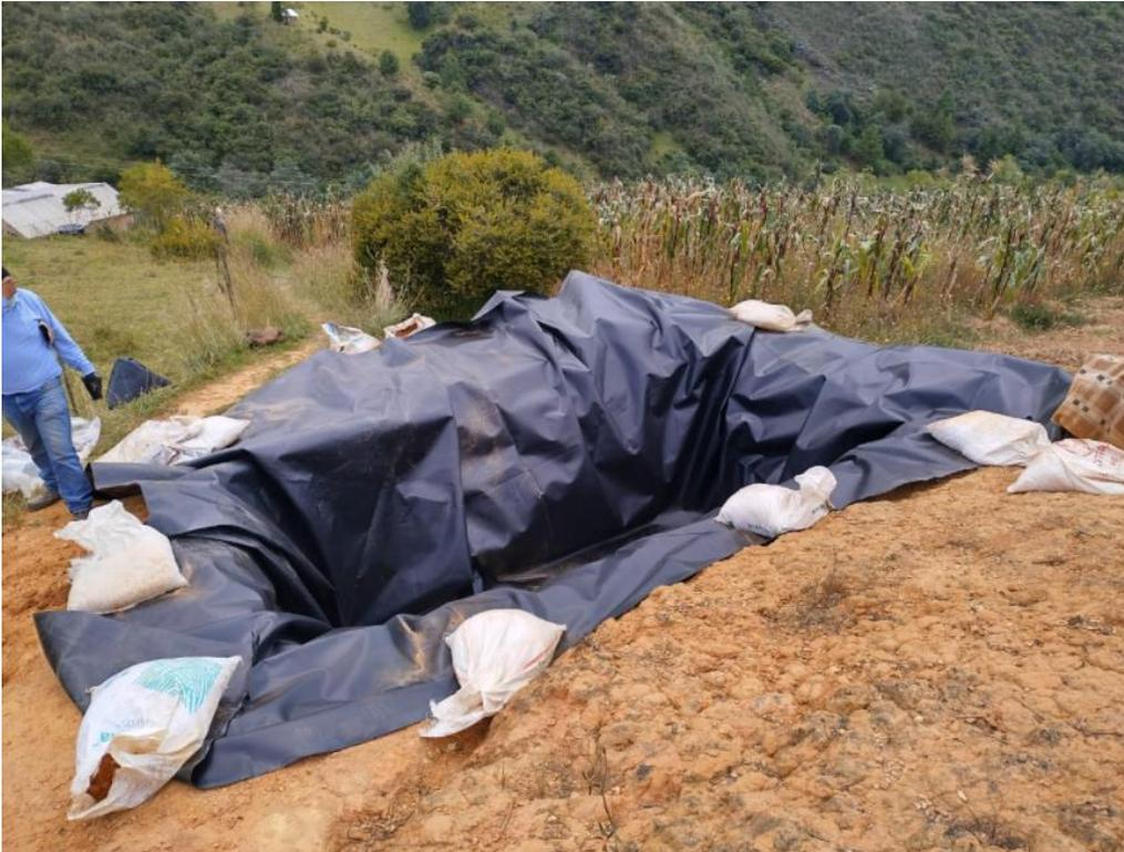
*Figura 46. Instalación geomembrana reservorio. Beteitiva. 2021.*
