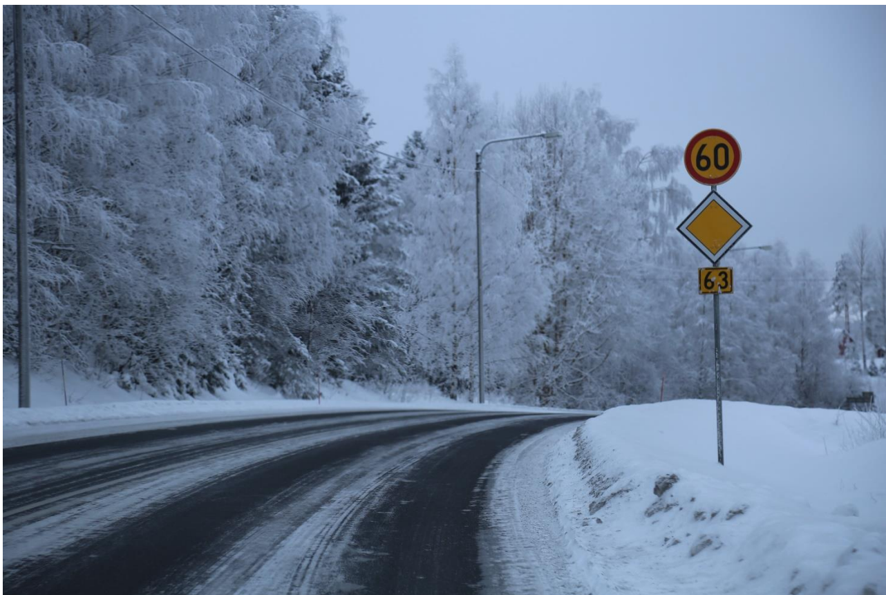
Bild 13. Hastighetsnivån på stamväg 63 är låg på grund av brister i geometrin, bybebyggelsens närhet och det stora antalet anslutningar.
