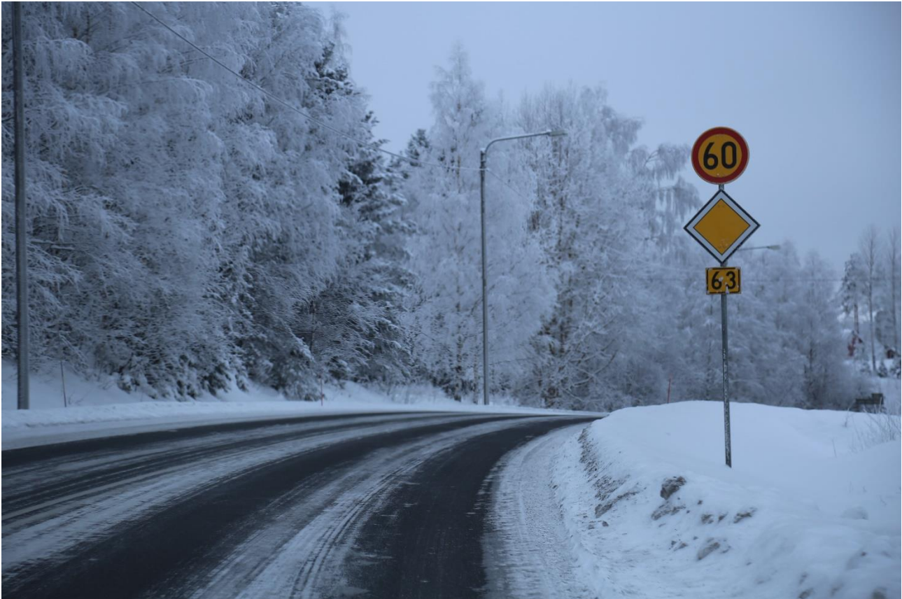
Kuva 13. Kantatien 63 nopeustaso on alhainen puutteellisen geometrian, läheisen kyläasutuksen ja suuren liittymämäärän takia.
