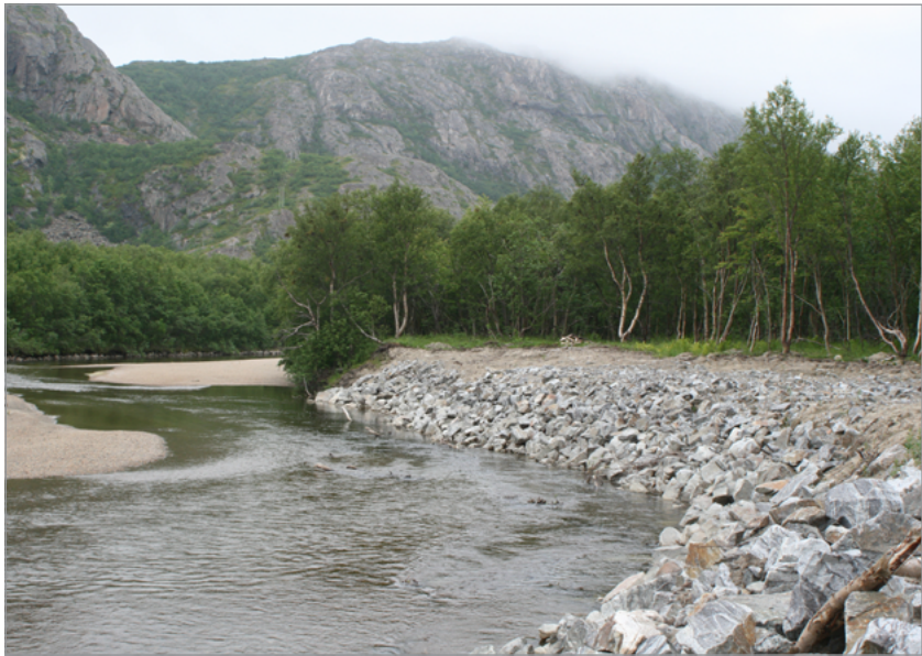
Eroosiosuojauksia Vuoremijoella. Kuva: Natalia Polikarpova.
