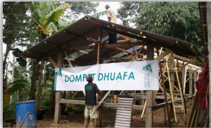
Gambar 6 Proses Pembangunan Kandang
