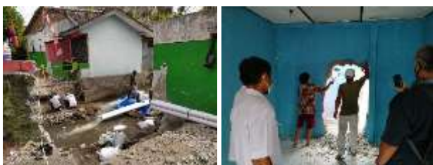
Gambar 4. Pembongkaran rumah di tepi sungai Belik untuk membangun jalan inspeksi.
