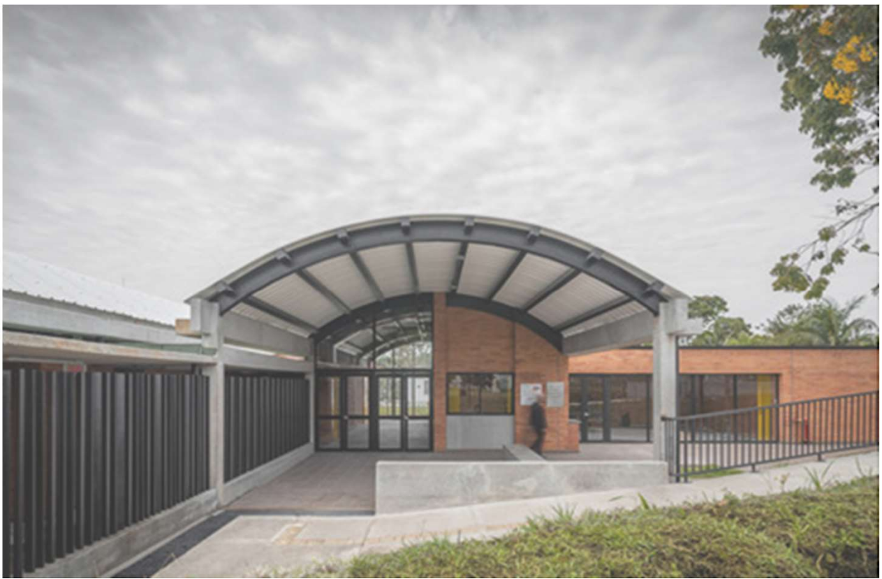
Figura 49, Ingreso al centro de desarrollo infantil El Porvenir, Fotografía de Mauricio Carvajal en Plataforma Arquitectura, "Centro de desarrollo infantil El Porvenir / Taller Síntesis" https://www.plataformaarquitectura.cl/cl/936477/centro-de-desarrollo-infantil-el-porvenir-taller-sintesis
