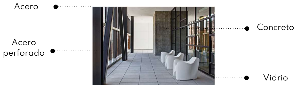
Figura 42. Centro de arte Hardesty. Imagen en Plataforma Arquitectura cl, "Centro de Arte Hardesty / Selser Schaefer Architects". https://www.plataformaarquitectura.cl/cl/757579/centro-de-arte-hardesty-selser-schaefer-architects?ad_medium=gallery
