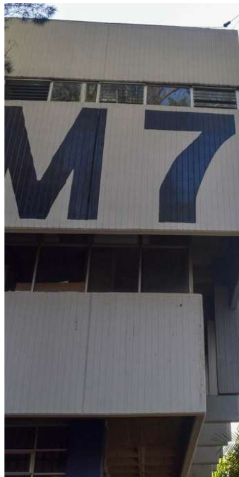
Figura 2: Edificio M7 de la Facultad de Medicina Veterinaria y Zootecnia. Fotografía brindada por la institución
