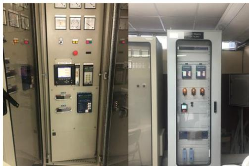
Fuente: Tablero de protección en casa de máquinas, Planta Hidroeléctrica Palín II.
