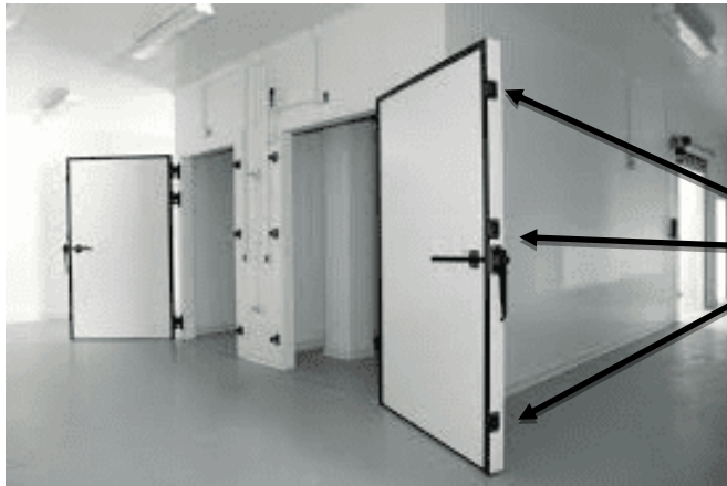
Figura 42. Sistema de enclavamiento para cuartos fríos
