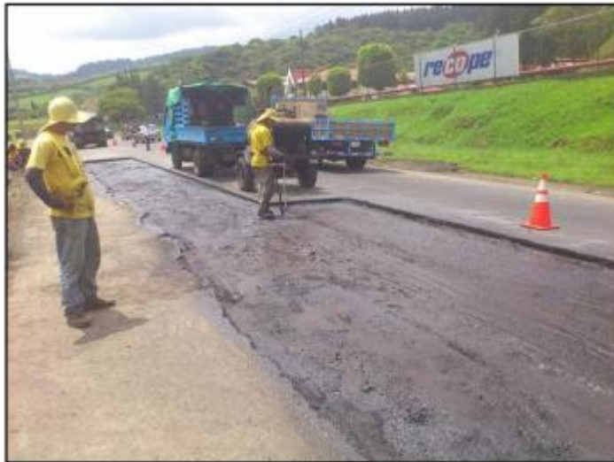
Figura 3. Área de carretera a bachear
