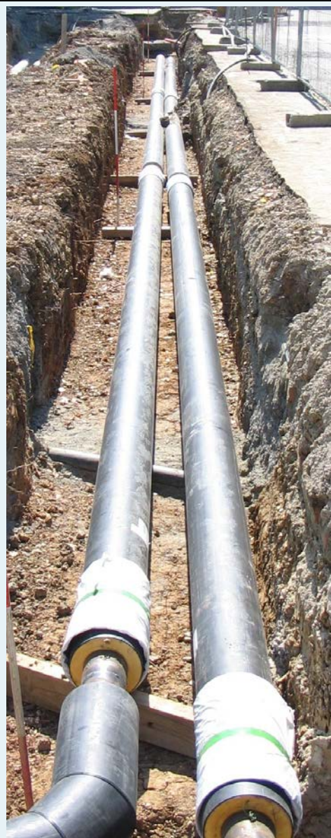
Abbildung: Fernwärmeleitung in der Bauphase (Tübingen),
