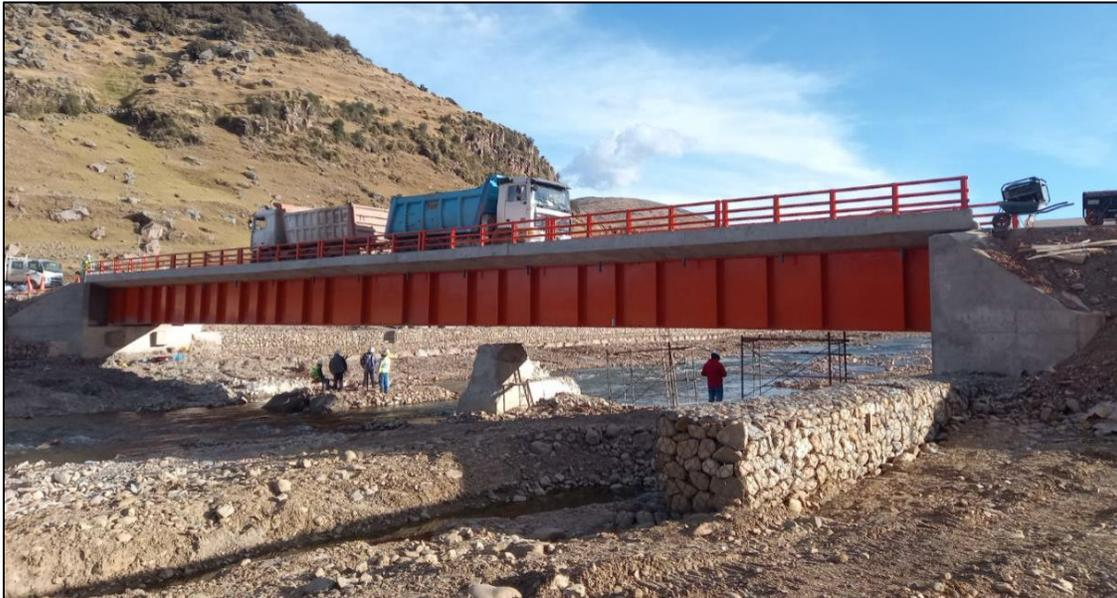
*Comentario: Se colocaron los volquetes en forma contrapuesta debido a que el puente es de una sola vía, también se visualiza al equipo técnico debajo de la superestructura para la toma de datos.*
