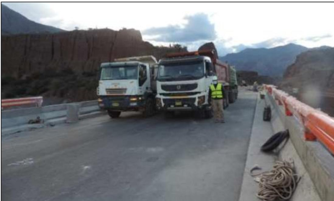
*Comentario: Se aprecia los 04 volquetes colocados en sus puntos respectivos para el inicio de la prueba de carga en el medio de la luz del puente.*
