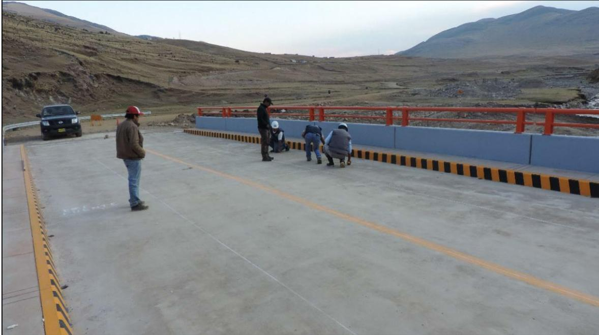
*Comentario: Se realizó un trazado de los ejes en el tablero del puente, antes de la colocación de cargas para la prueba de carga.*
