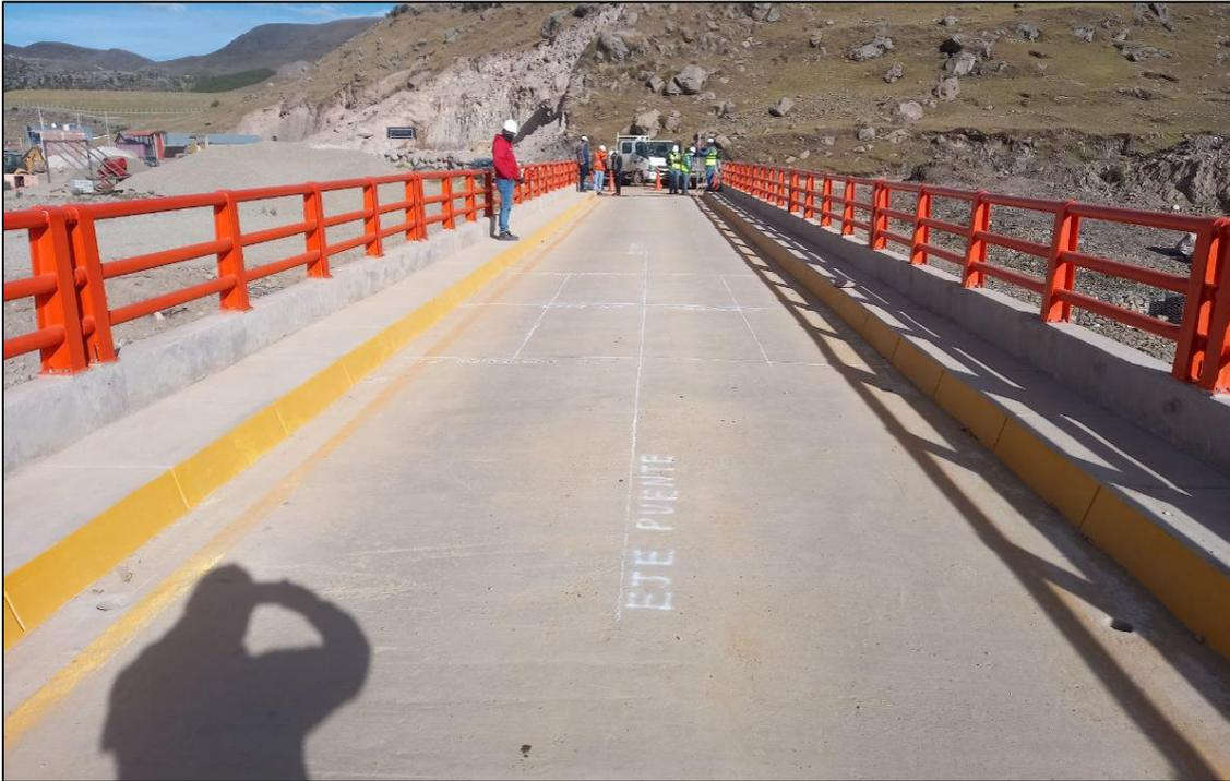
*Comentario: Se realizo un trazado de los ejes en el tablero del puente, antes de la colocación de cargas para la prueba de carga, este puente era de una sola vía.*
