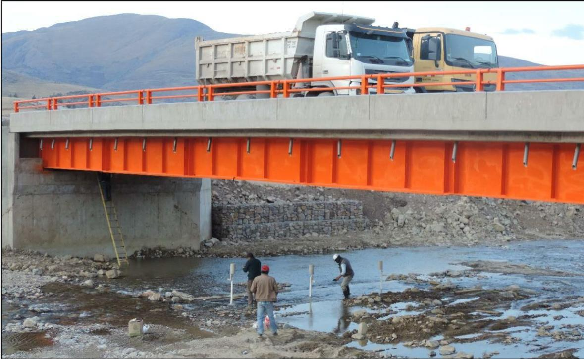
*Comentario: Antes de la colocación de las cargas en la superestructura, se posicionaron los deformímetros en medio de la luz de puentes para su respectiva lectura.*
