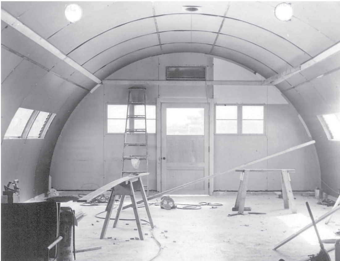
Figura 9. Interior de una de las Quonset Huts de Rota, 1960.
