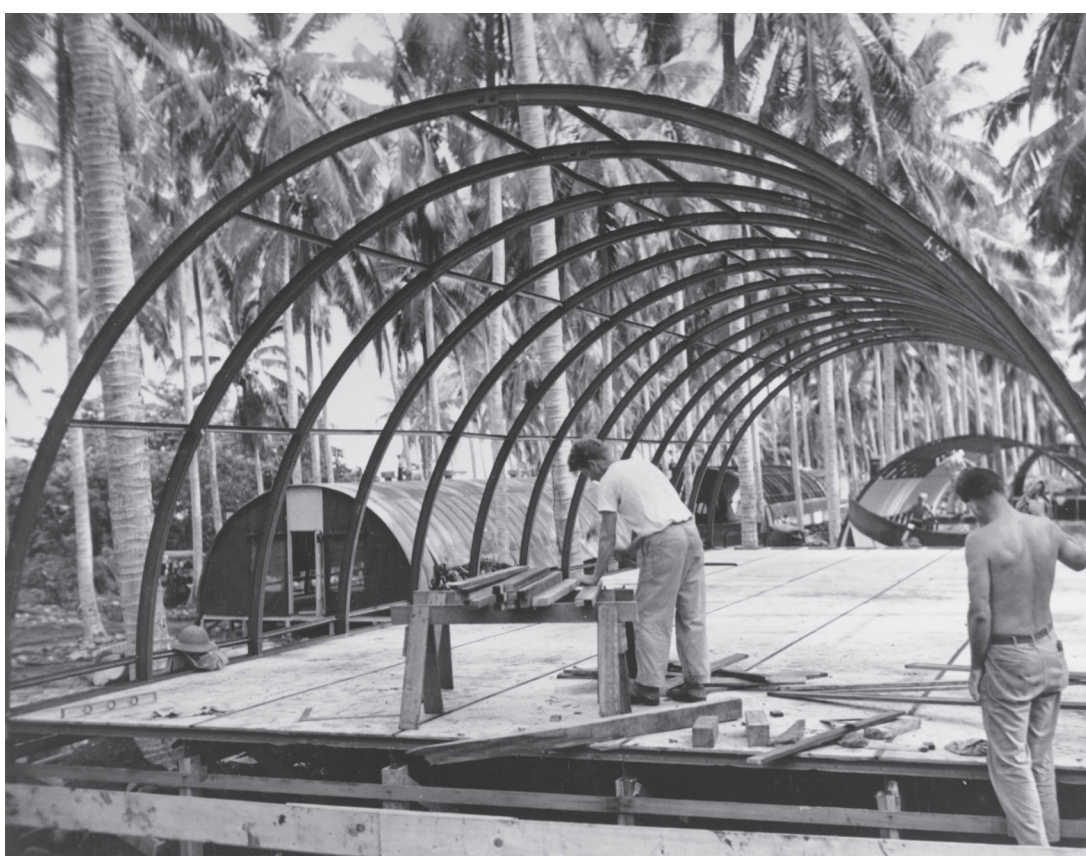
Figura 1. Construcción de una Quonset Hut en 1943 en Russell Islands, en el Pacífico.
