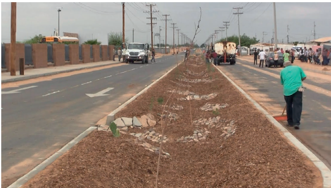
Figura 1 | Habilitación de una cuneta como zanja de infiltración en el Blvd. Jalisco de San Luis Río Colorado (Sonora, México). Imagen tomada de https://watershedmg.org/newsmedia/infraestructura-verde-en-san-luis-rio-colorado .
