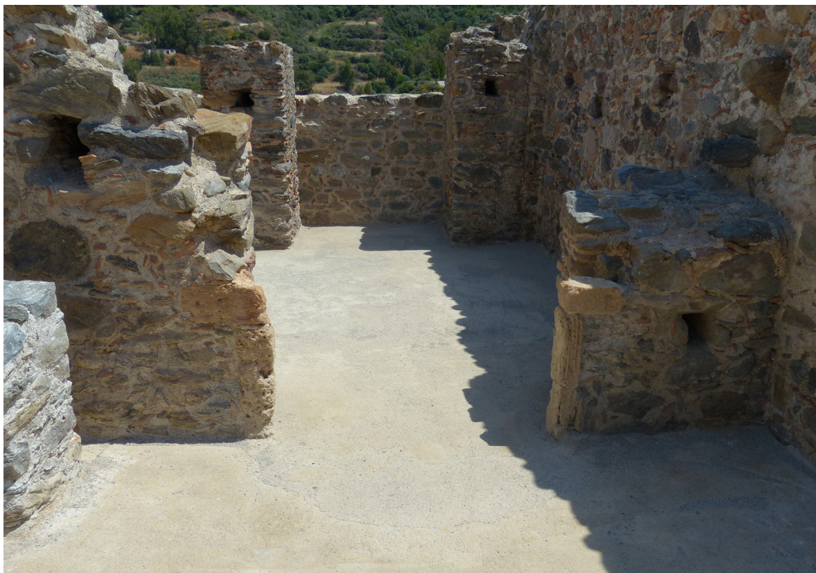
Εικ. 26. Κάστρο Βατίκων. Θύρα του κτηρίου Γ (2018).
