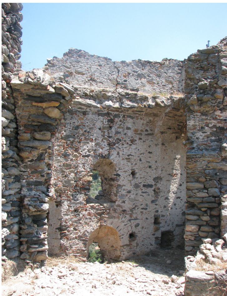
Εικ. 15. Κάστρο Βατίκων. Ο ανατολικός τοίχος του κτηρίου Ε (2010).
