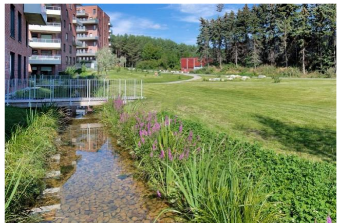
Figur 10: Foto av kanalen som er konstruert for å opprette holde vannspeil og fordrøye vann. © Selvaag Bolig ASA
